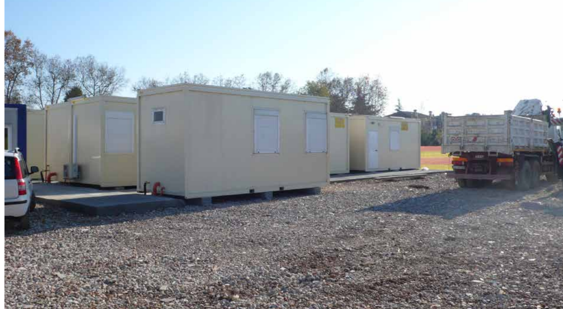
Baraccamenti di cantiere.
