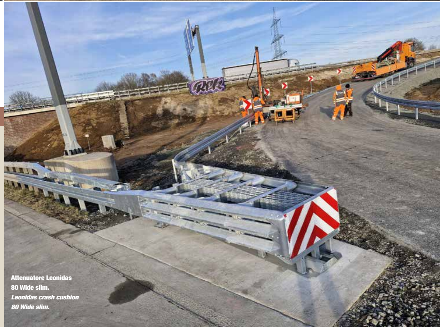
I dispositivi SMA sono stati ancorati su basamento in calcestruzzo armato. SMA devices have been anchored to the concrete basement.
