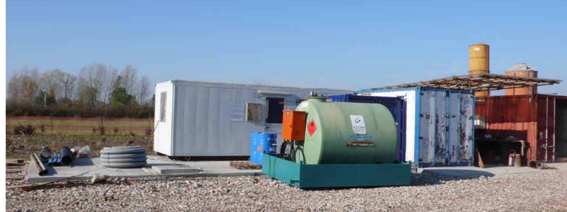
Impianti e magazzini. In secondo piano, l'impianto del calcestruzzo con i due silii.
