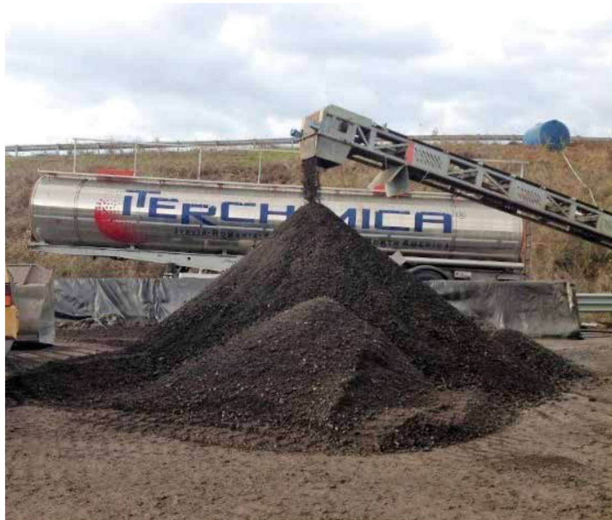
Figura 2. Riciclaggio a freddo con emulsione.
