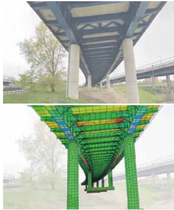
Fig. 6: Confronto tra il viadotto Forlanini e il suo gemello digitale. Fig. 6: Comparison between the Forlanini viaduct and its digital twin.
