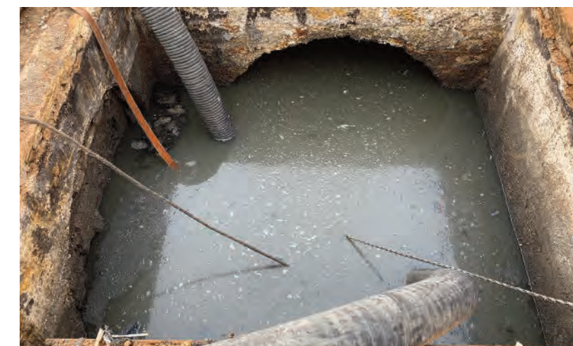
Il lavoro delle tre elettropompe ha consentito il livello del reflu al di sotto della paratia di sezionamento, permettendo di lavorare sotto battente.
