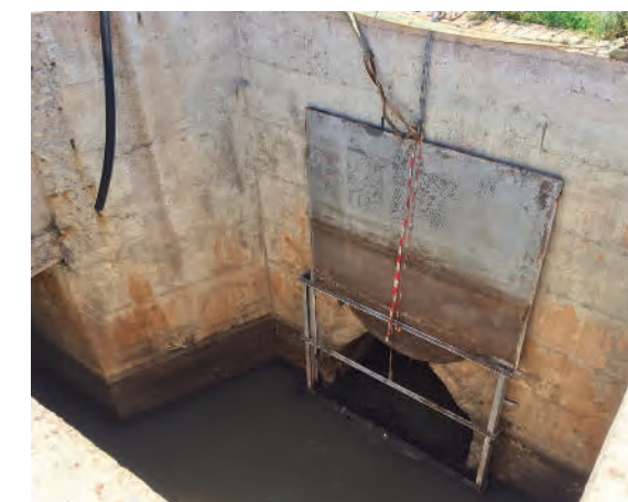
Il lavoro delle tre elettropompe ha consentito il livello del reflu al di sotto della paratia di sezionamento, permettendo di lavorare sotto battente.
