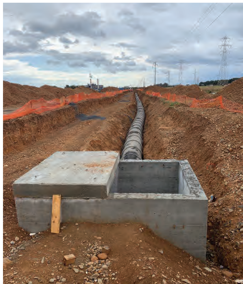
Fase di reinterro della nuova rete.
