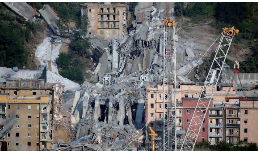
Le macerie del Ponte Morandi, in parte utilizzate per il Memoriale.
