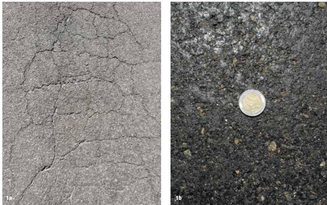
**Fig. 1:** Pavimentazione pre (sinistra) e post (destra) intervento con impiego di Iterlene ACF 1000 HP Green.
