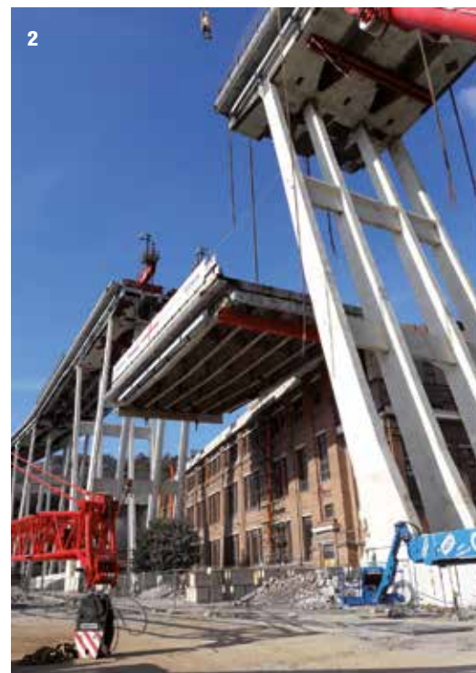
2. Particolare del sistema "strand jacks"
