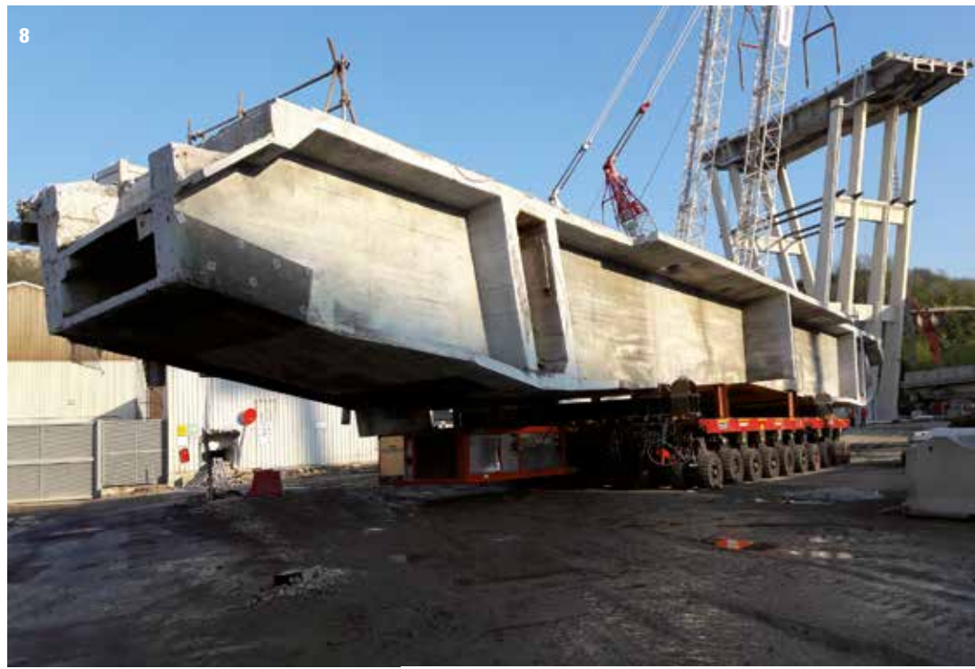
7, 8, 9. Operazione di rimozione delle sezioni tramite carrelli speciali SPMT
