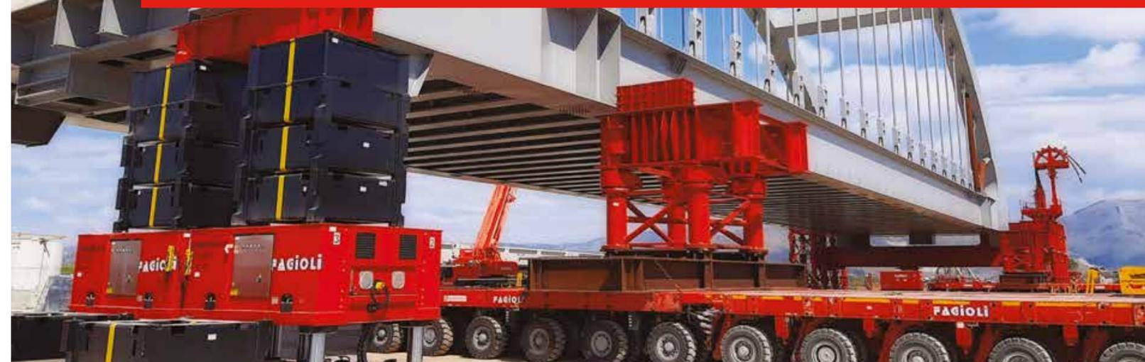
Trasporto, sollevamento e installazione di un ponte ferroviario da 2.500 tonnellate per la nuova tratta dell'Alta Velocità Napoli - Bari
